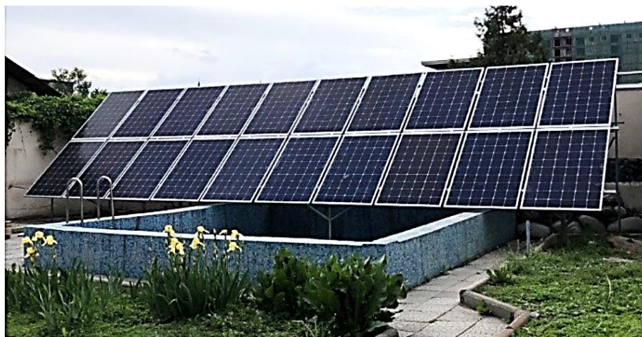
Рисунок 4. Установка автономной солнечной станции
