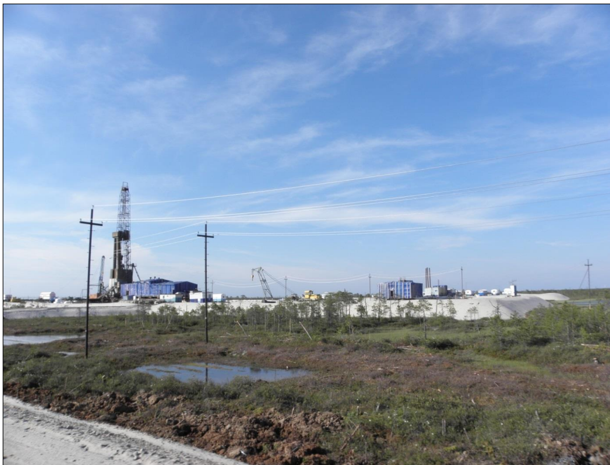
Рисунок 4. Промышленные площадки с нарушенным растительным покровом вокруг.
