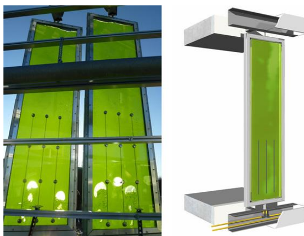
Рисунок 2. Внешний вид панелей SolarLeaf с демонстрацией основных особенностей устройства ( https://clck.ru/GXNxF ).
