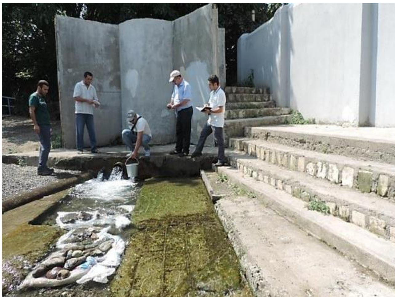
Рисунок 1. Общий вид выхода кяризов
