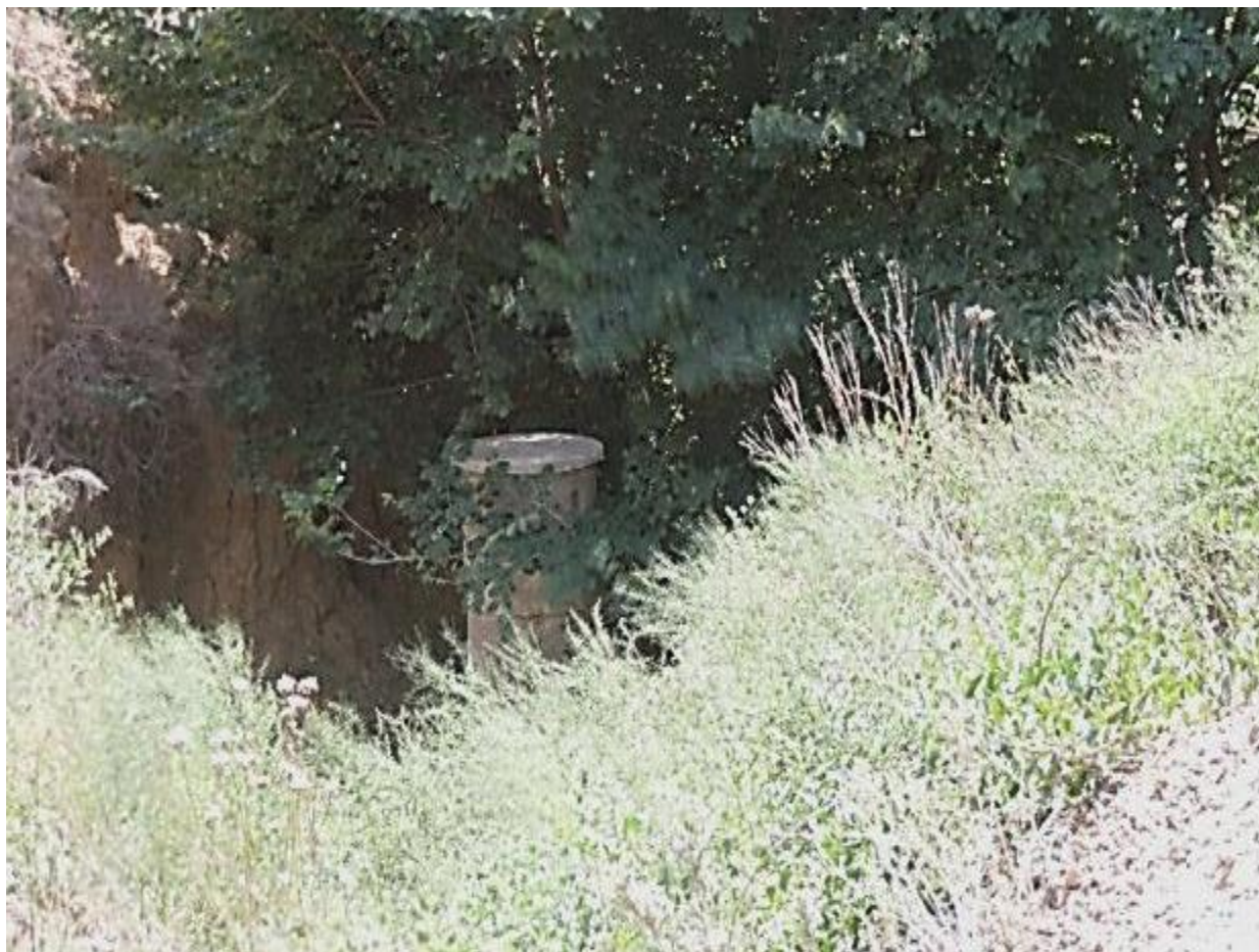
Рисунок 2. Общий вид наблюдательной скважины
